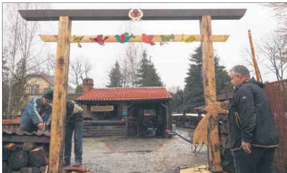
Brama torii podczas budowy
