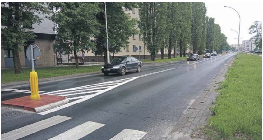
Modernizacji poddany zostanie odcinek drogi od skrzyżowania przy bazylice konkatedralnej do przejazdu kolejowego.
