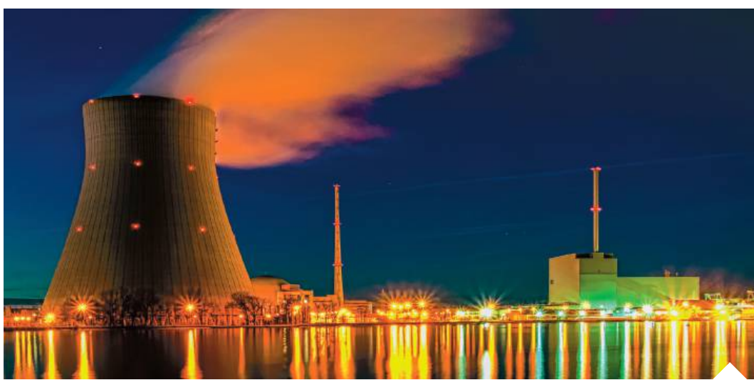
Ostatnie trzy niemieckie elektrownie jądrowe – Isar 2, Emsland oraz Neckarwestheim 2 – zostały właśnie wygaszone
