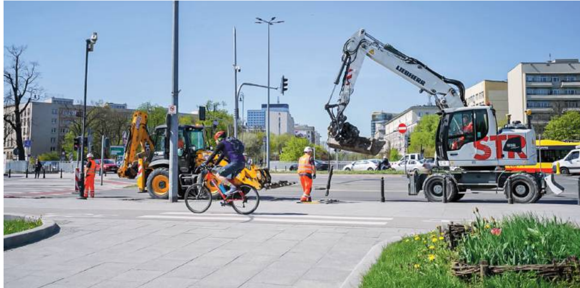
Przebudowa pl. Na Rozdrożu ma się skończyć w przyszłym roku | fot. mat. pras./d
