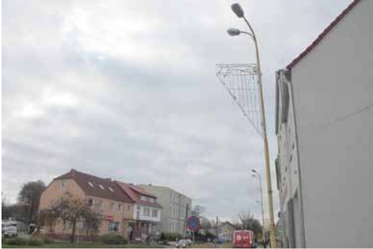
Ozdoby świąteczne zamontowano na latarniach przy głównych ulicach
