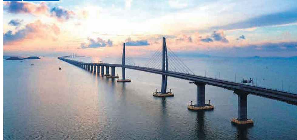
Otwarto najdłuższy most na świecie (ponad 55 km), łączący kontynentalne Chiny z Hongkongiem. Przeprawa przecinająca ujście rzeki Perłowej połączyła trzy miasta Hongkong, Zhuhai i Makau.
