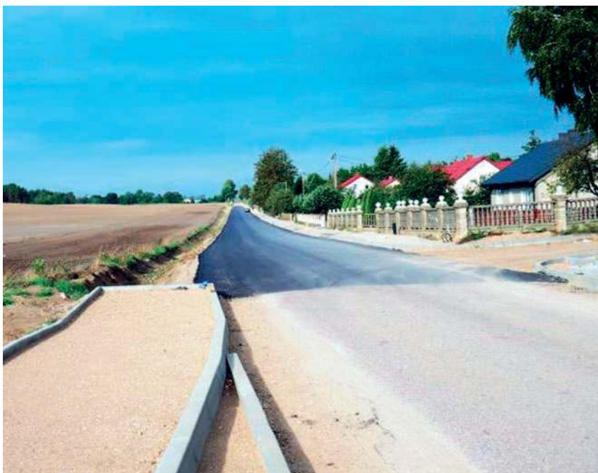
Odcinek remontowanej drogi
