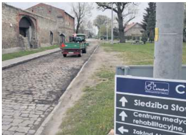
Mikoszów. Jeszcze niedawno w tym miejscu było więcej dziur niż asfaltu
