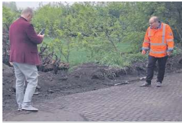
Górzec. W trakcie prac porządkowych przed zrywaniem zdewastowanej nawierzchni okazało się, że droga jest szersza. Na zdjęciu Artur Gulczyński i Waldemar Łysiak
