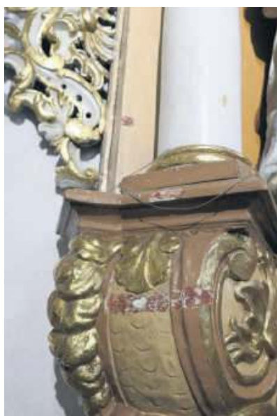
Uszkodzone, rzeźbione elementy ołtarza. Podczas renowacji zostaną usunięte kolejne warstwy przemalowań, aby dotrzeć do pierwotnej kolorystyki rzeźb
