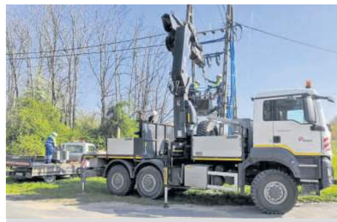
Zakład energetyczny wymienił transformator u zbiegu ulic Miodowej i Akacjowej
