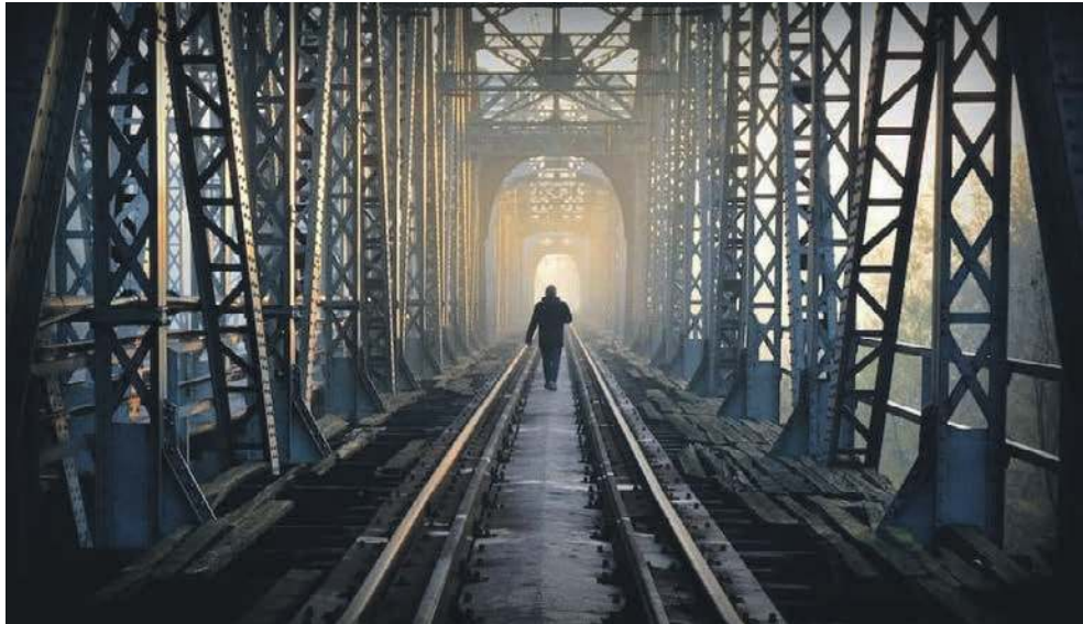
Most kolejowy w Zatorze
