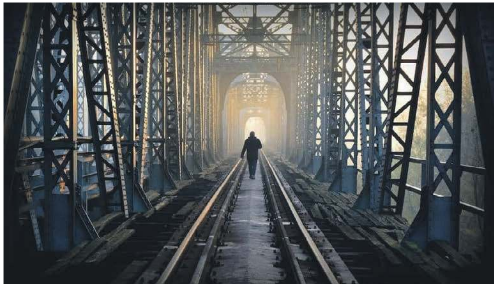
Most kolejowy w Zatorze
