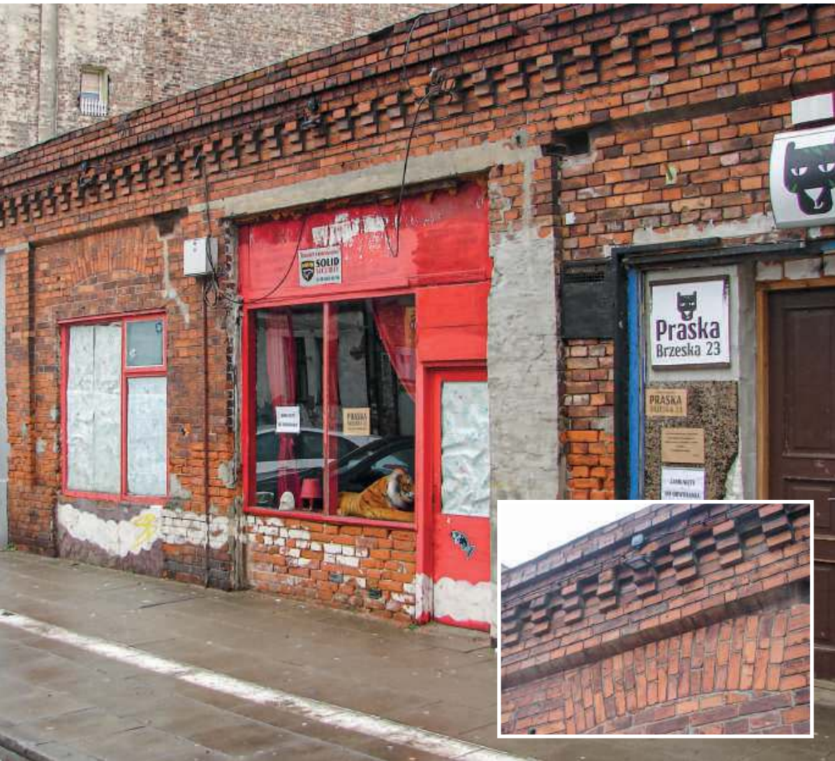
Ogólny widok murowanych kramów przy ul. Brzeskiej 23 i fragment elewacji zabytku | fot. Janusz Sujecki/Gazeta Polska
