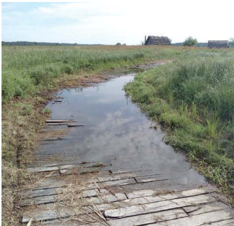
Drewniana alejka ma zostać przebudowana. W planach jest też budowa 15-metrowego pomostu, który umożliwi wejście na teren Grodziska nawet w okresie podtopień
