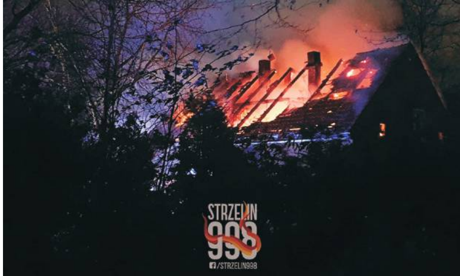
Po północy, 6 stycznia, w Kazimierzowie wybuchł pożar budynku mieszkalnego. W toku wykonywanych czynności na parterze domu natrafiono na zwęglone zwłoki mężczyzny. Foto: Strzelin998
