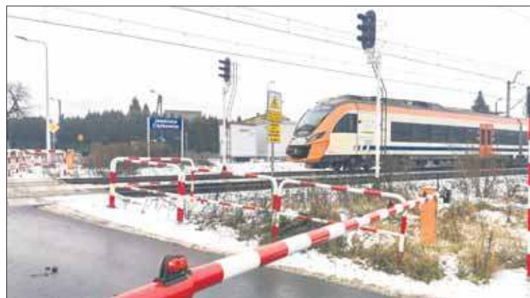
Wiadukt ma zostać ukończony w 2023 roku
