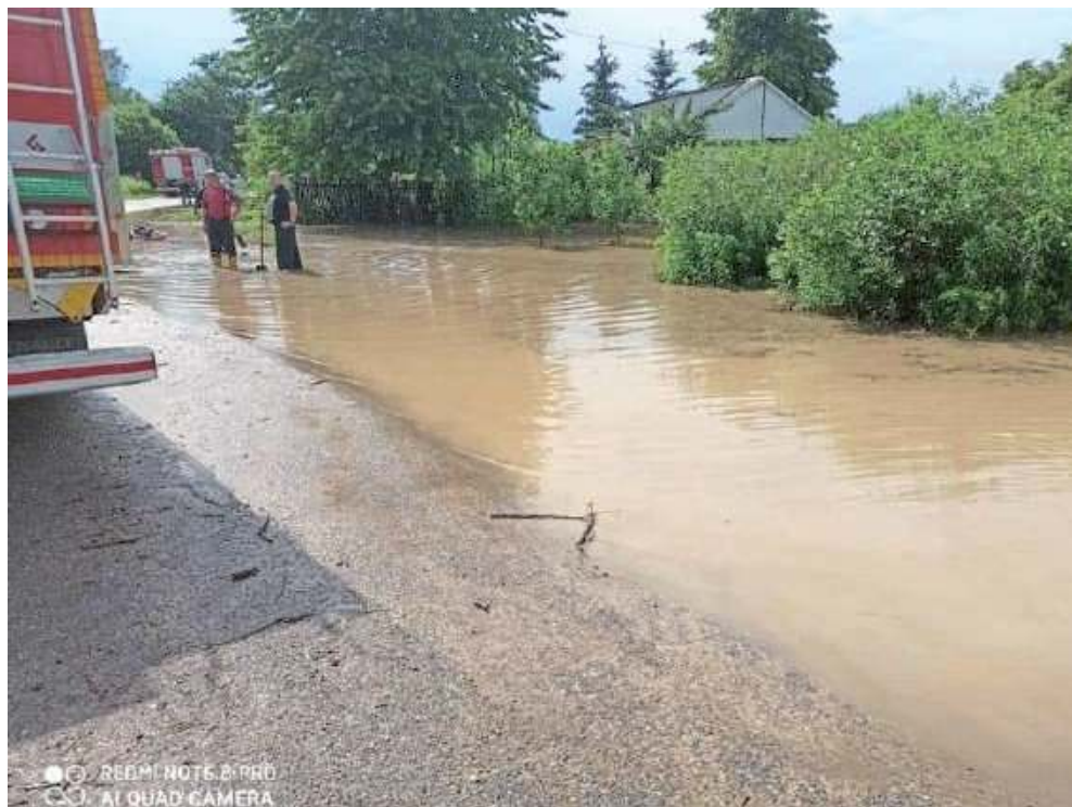
W Chruślinie nowa nawierzchnia pojawi się na ponad 3,3 km odcinku zniszczonym podczas letniej nawałnicy
