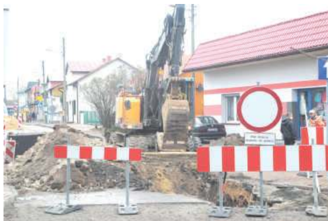
Piekarska zamknięta została dla ruchu w związku z budową kanalizacji deszczowej
