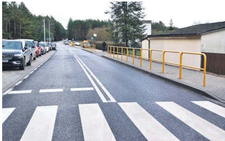
Fragment zmodernizowanej drogi, przebiegający przez Wielkie Gacno.
