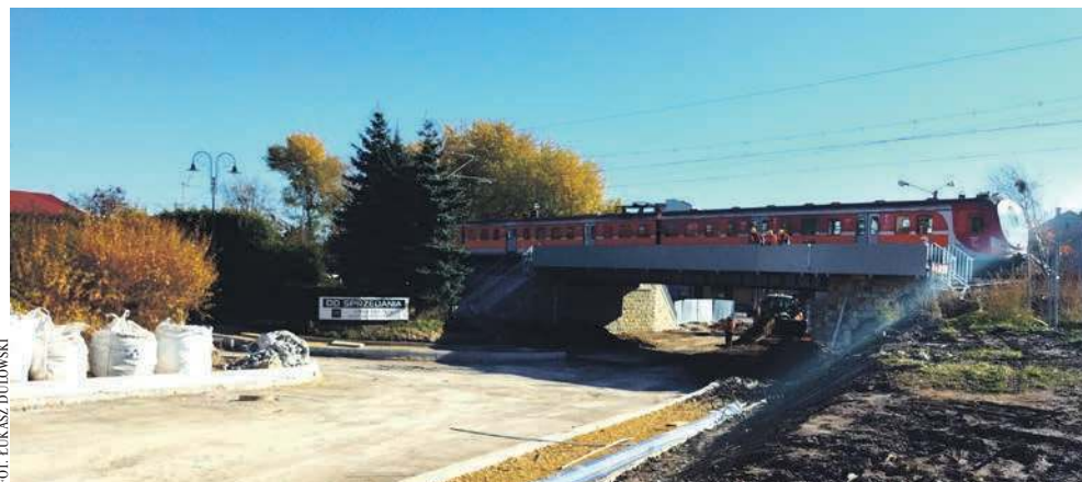
Zmodernizowany wiadukt kolejowy nad Krakowską w Chrzanowie
