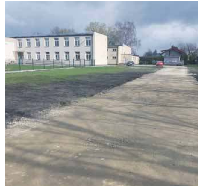
Takiej jakości skrót ułatwia, czy też utrudnia dojście i dojazd do budynków przy ulicy Młyńskiej?
