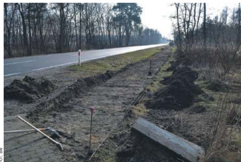
Budowa chodnika wzdłuż drogi krajowej nr 77 w Kopkach będzie kosztowała przeszło 2 mln zł
