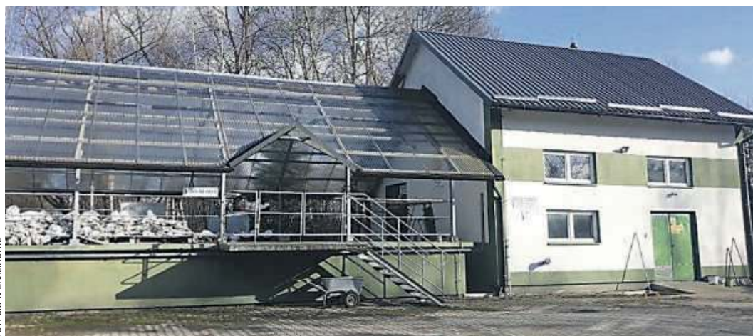
Oczyszczalnia ścieków przed modernizacją
