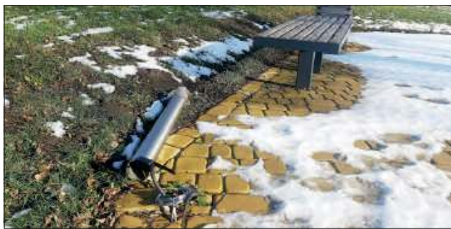
Jedna z uszkodzonych lamp. Zdjęcie wykonano 21 stycznia. Jak widać do tego czasu nie doczekała się naprawy.
