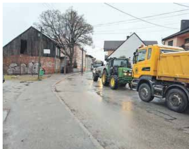
We wtorek rozpoczął się remont ul. Nadwodniej.
