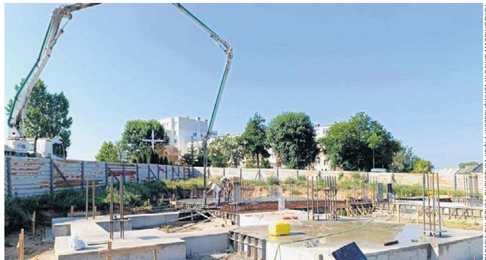
Ekipy wylały już fundamenty pod budowę świątyni
