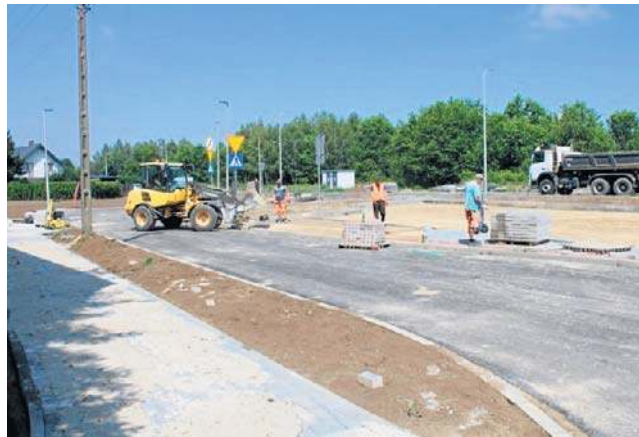
Rozbudowa strefy inwestycyjnej w Radomsku na ukończeniu
