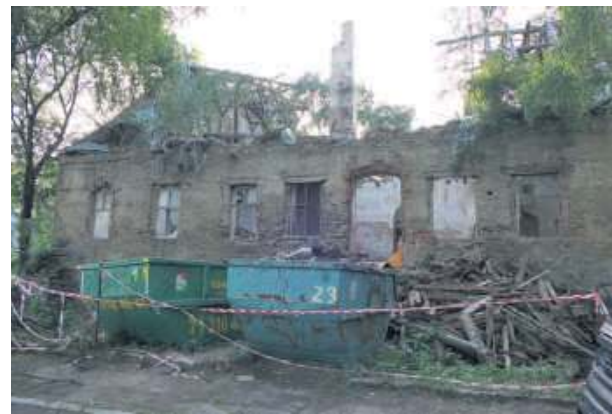
Kontenery na odpady świadczą, że praca wre. Obecnie usuwane jest głównie spróchniałe drewno i gruz
