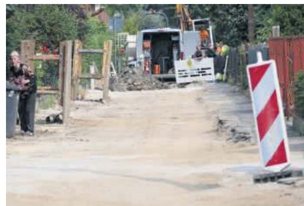
Trwają prace remontowe na ulicy Żwirki i Wigury w Strzelinie
