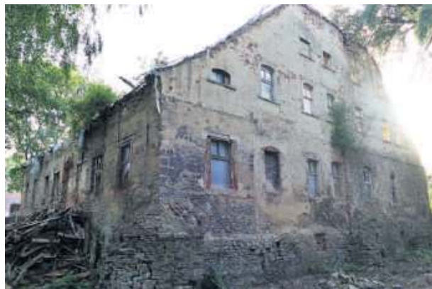
Po usunięciu krzewów i drzew, okazało się, że budynek jest naprawdę duży. Tylko na parterze ma aż 500 metrów kwadratowych.
