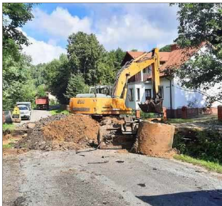
Prace przy powiatówce trwają. To dla wielu osób historyczny moment, bo o remont drogi zabiegano od wielu lat.
