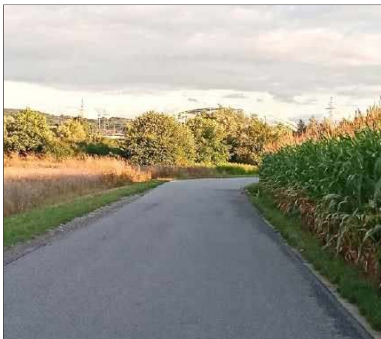
Niebezpieczne zakręty na Błyszczówce.
