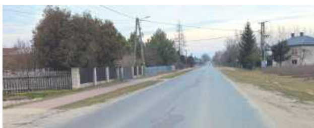
Droga powiatowa nr 1126L łączy gminę Międzyrzec Podlaski z gminą Drelów
