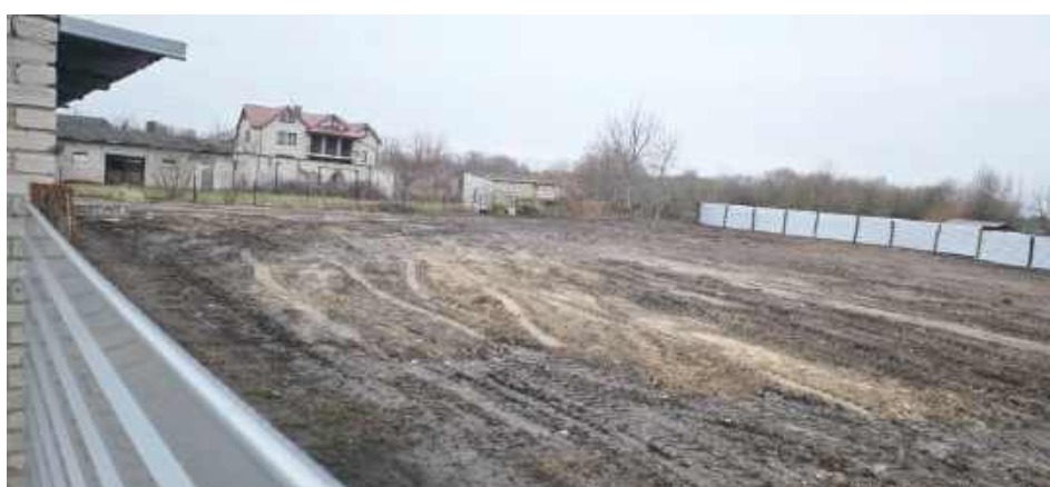
Teren przy ul. Wspólnej został wyrównany i przygotowany do prac ziemnych
