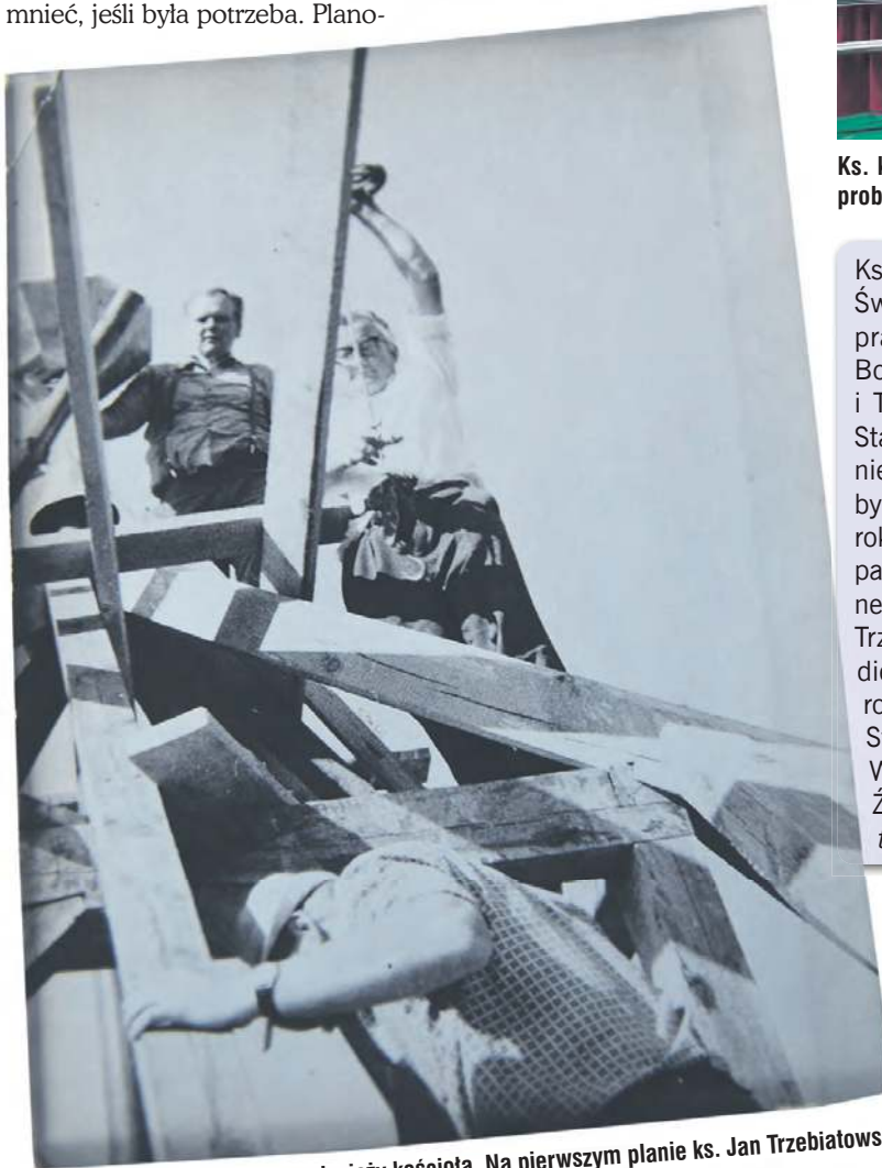
Montowanie krzyża na budowanej wieży kościoła. Na pierwszym planie ks. Jan Trzebiatowski. Zdjęcie zrobiono w 1981 roku.
