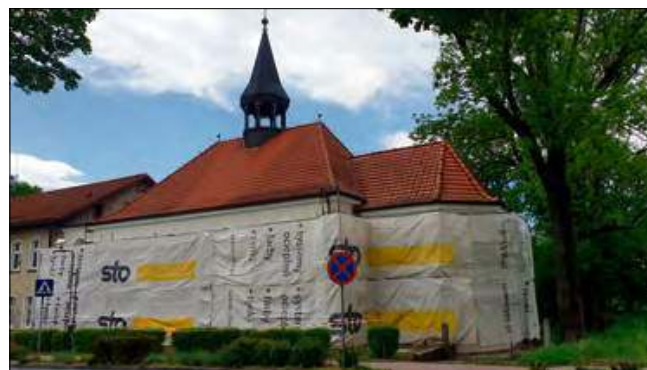
W kościele filialnym prowadzony jest remont elewacji.
