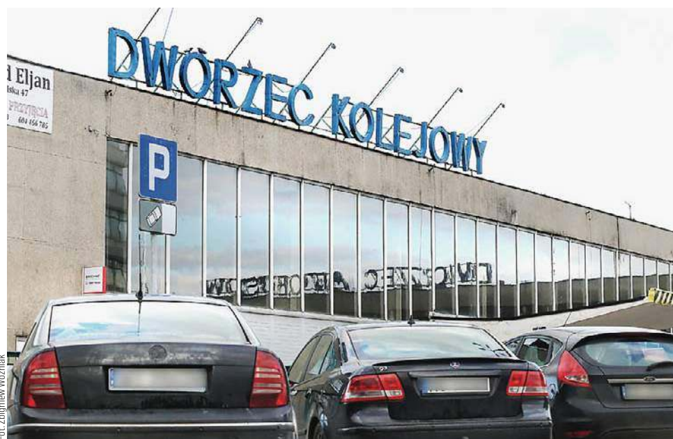
Budowa nowego dworca zakończy się prawdopodobnie w połowie 2023 roku
