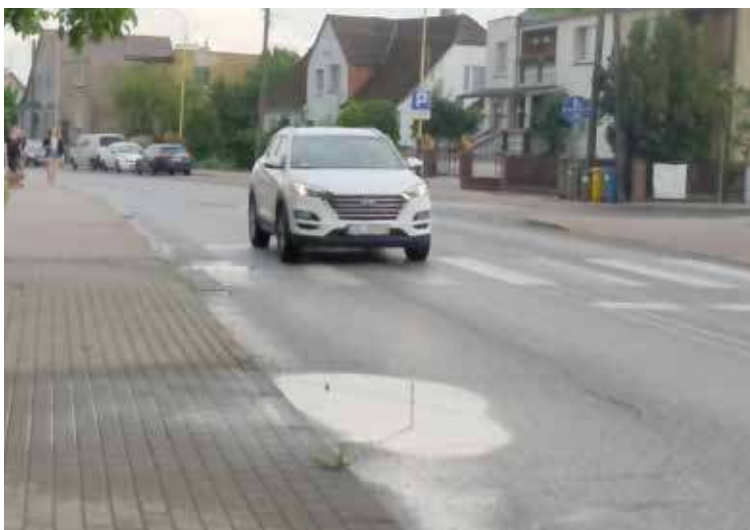
Kałuża na Bohaterów Warszawy przy sklepie nie daje mieszkańcom spokoju
