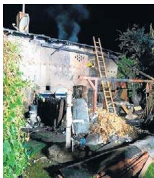
Ogień zajął warsztat oraz kotłownię
