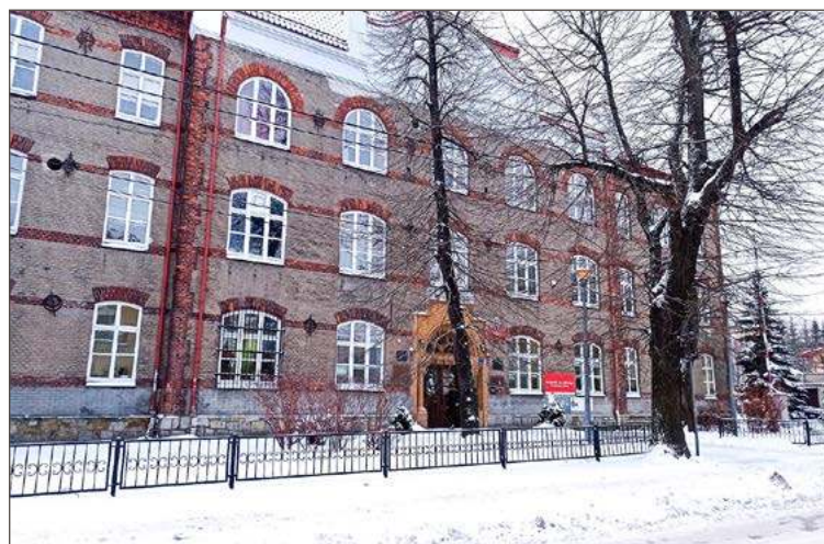
I Liceum Ogólnokształcące w Dębicy doczeka się remontu elewacji.
