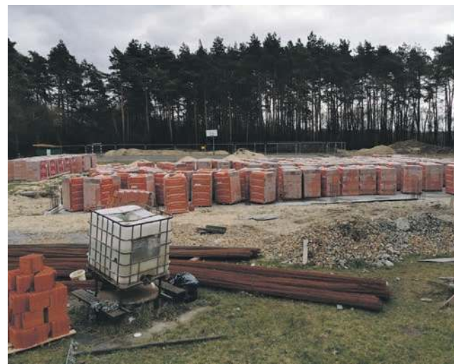
W tym miejscu powstaje sala gimnastyczna
