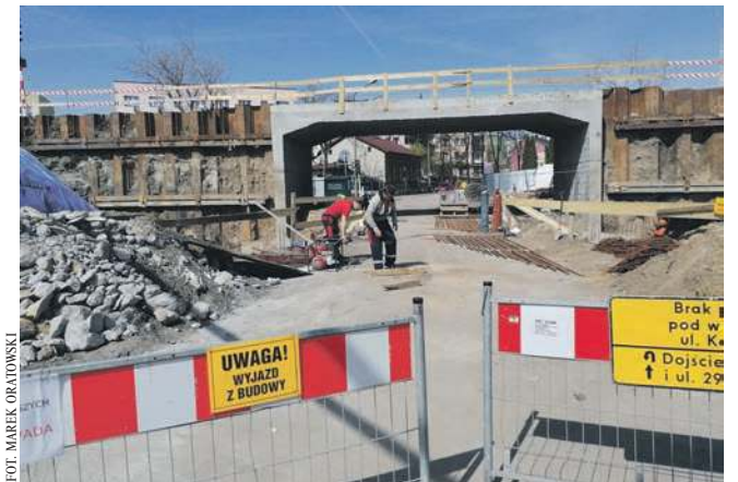
FOT. MAREK ORATOWSKI Trwają prace przy wiadukcie nad ul. Kadłubek
