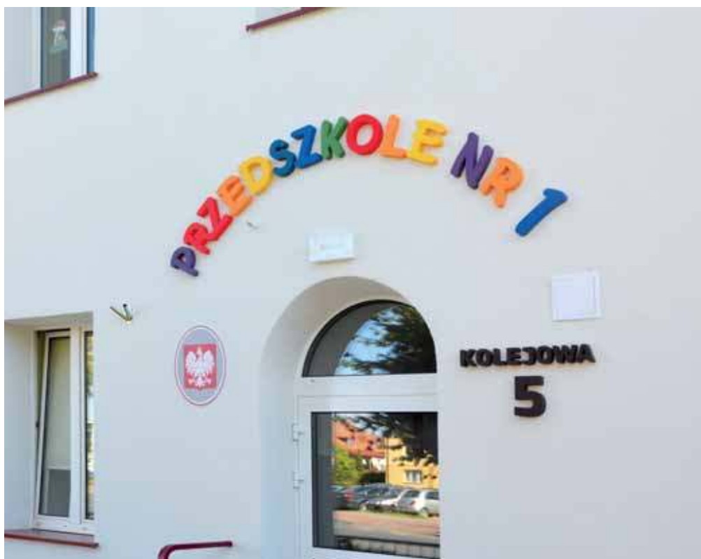
...i po modernizacji
