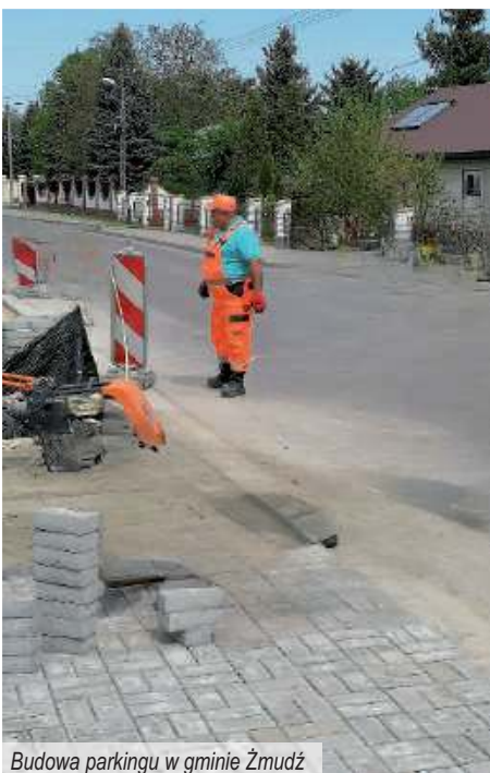
Budowa parkingu w gminie Żmudź
