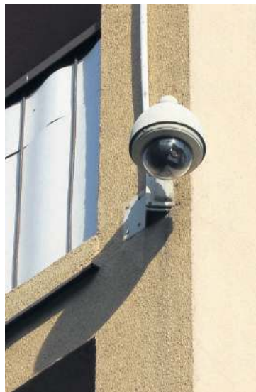
W ramach kolejnego przetargu przewidziano budowę punktu kamerowego w strzelińskim Parku Miejskim im. Armii Krajowej
