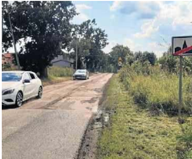
Trzeba liczyć się z utrudnieniami w ruchu. Dzisiaj drogowcy zaczną wylewać pierwszą warstwę asfaltu
