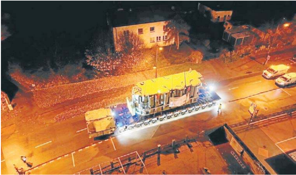
Transformatory na teren budowy nocą przewieziono z portu we Władysławowie
