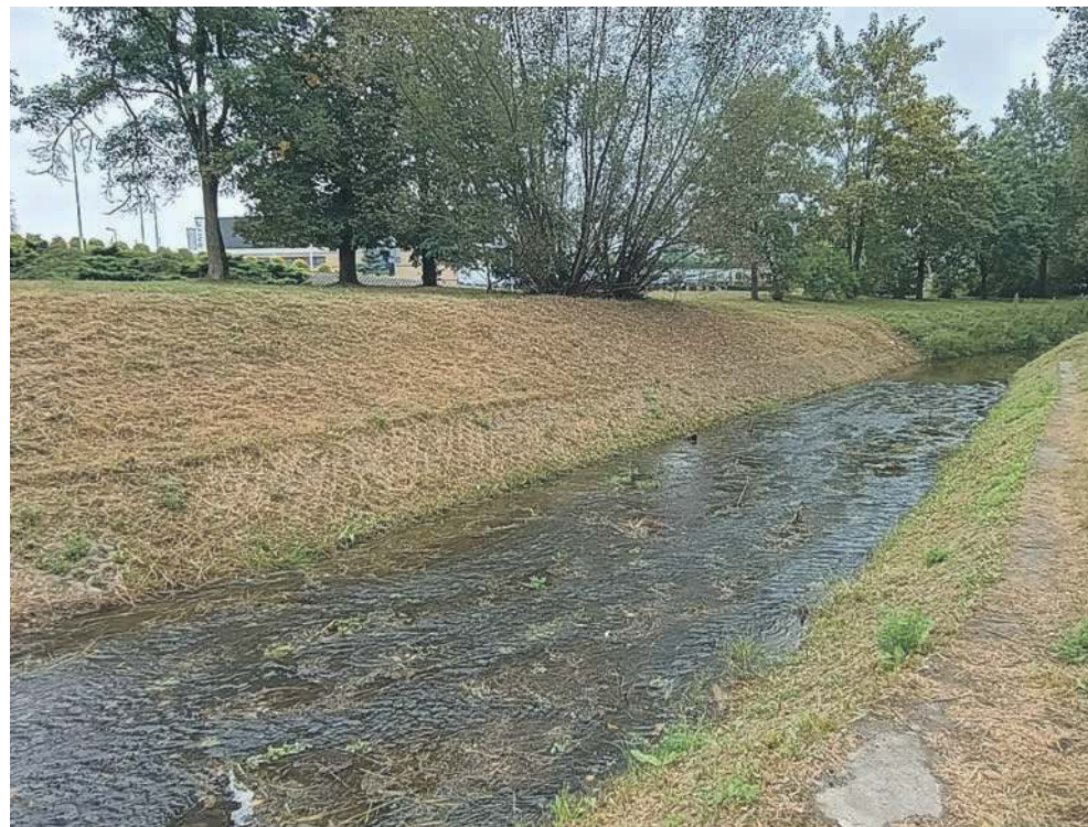
Rekordowo niski poziom wody widać m.in. w Luszówce na wysokości bloków przy ulicy Trzebińskiej w Chrzanowie
