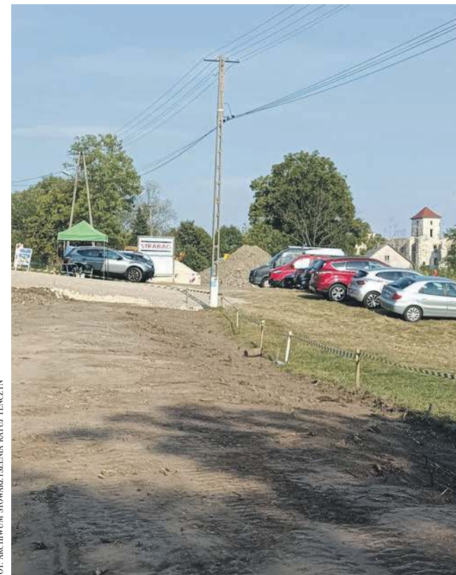
Modernizacja drogi w stronę zamku w Rudnie
