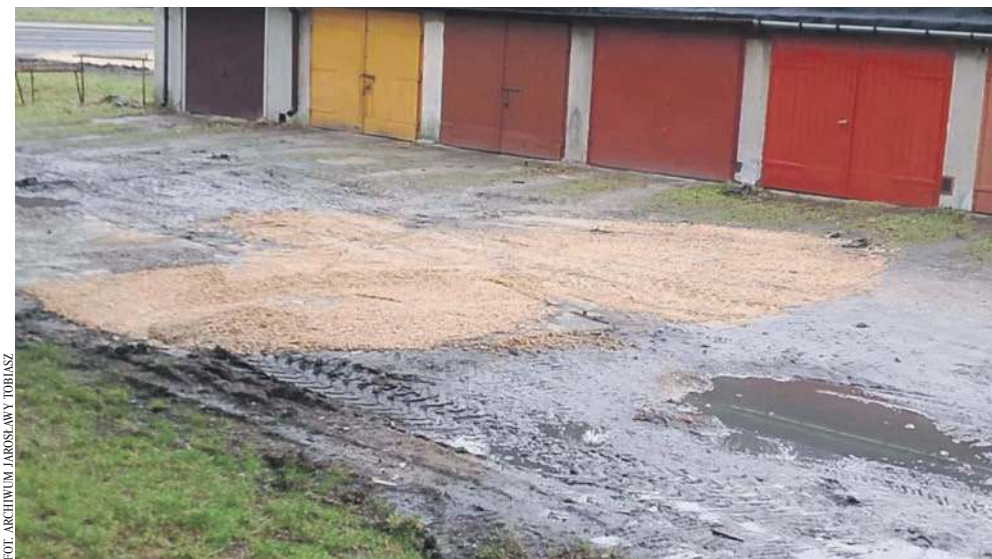
Zasypane zapadlisko obok garaży przy Rospontowej w Chrzanowie
