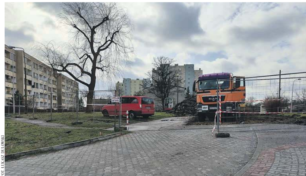
Garaże i miejsca postojowe powstaną między ul. Sienkiewicza i blokiem nr 4 przy Mieszka I
