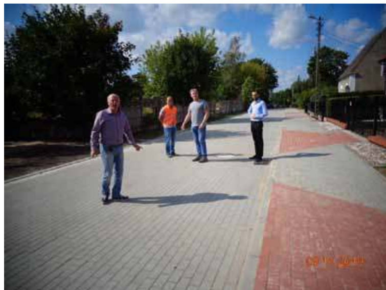
Burmistrz Chociwla, inspektor nadzoru budowlanego i przedstawiciel wykonawcy dokonali odbioru robót budowlanych
