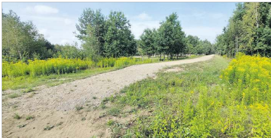
W bieżącym roku rozpocznie się realizacja trzeciego, a tym samym ostatniego etapu zadania związanego z rozbudową obwałowań rzeki Osa
