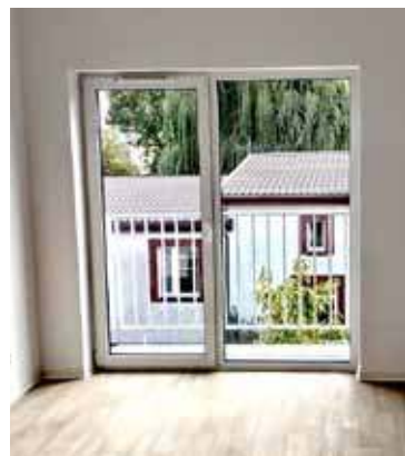
STBS przygotowało wykaz 15 lokali, które można samodzielnie wyremontować a następnie zamieszkać w nich
