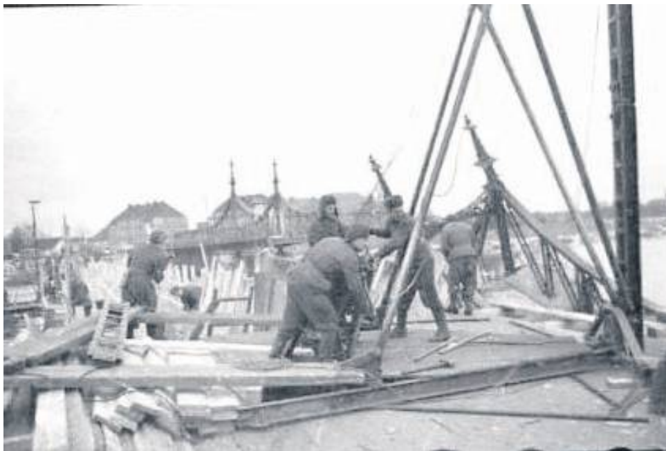
1945 - saperzy Armii Radzieckiej budują most drewniany na Odrze - po prawej szczątki mostu stalowego wysadzonego przez Niemców w styczniu 1945 roku.
