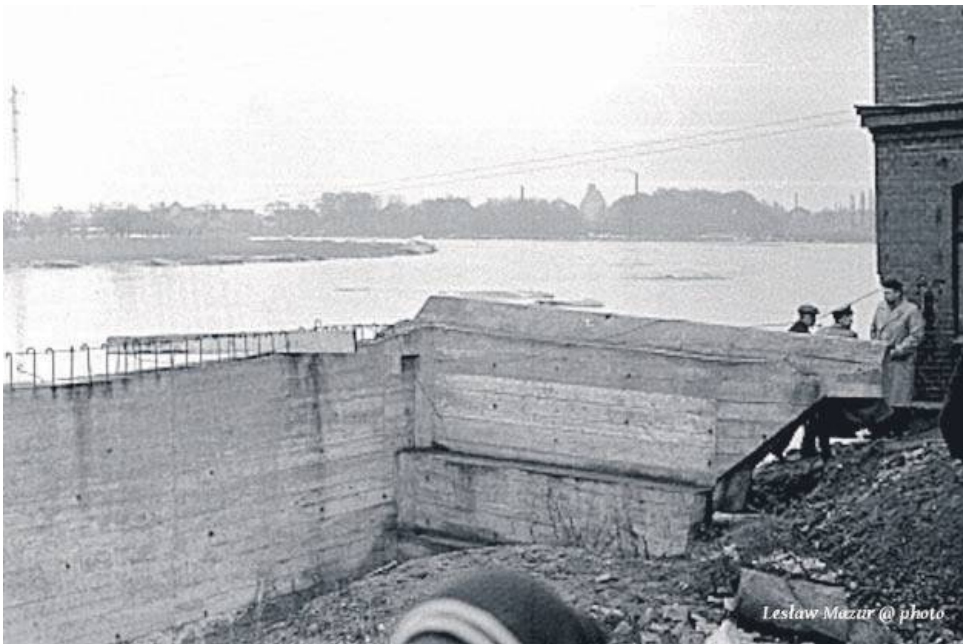
1963. Wylane fundament pod przyczółek mostu stalowego od strony miasta. Był on budowany nowoczesną na ówczesne czasy metodą. Konstrukcja mostu była montowana na ulicy Oleśnickiej i przesuwana na rolkach w stronę miasta. Po prawej widać stojący jeszcze wtedy budynek celny, w którym było stanowisko dowodzenia obrony mostu przed kra
