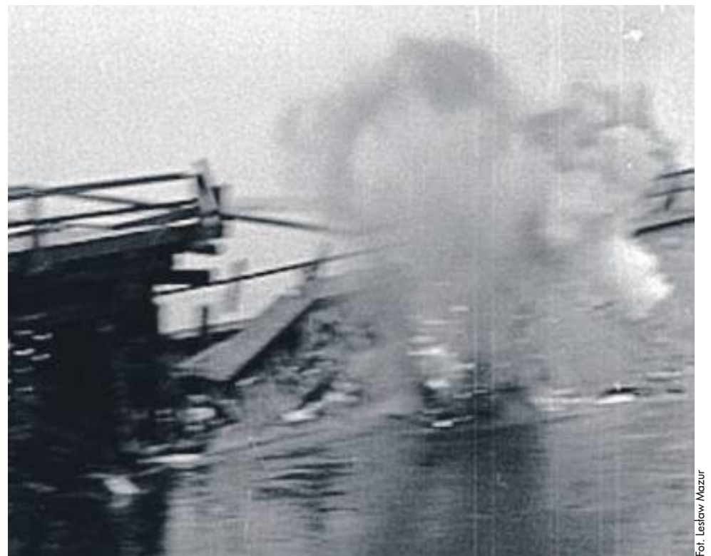
1963. Na zdjęciu zrobionym przeze mnie widać, jak ładunek trotylu wybucha na krze tuż przed zwalonym przęsłem. Gdyby kra nie została zniszczona, prawdopodobnie zniszczyłaby to przęsło do końca
