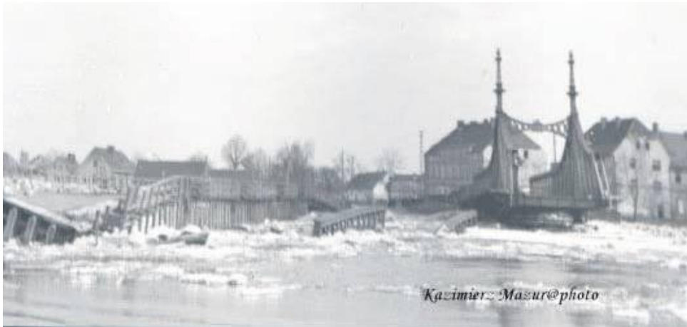
1947, wiosna, zniszczony przez krę lodową drewniany most, wybudowany w 1945
