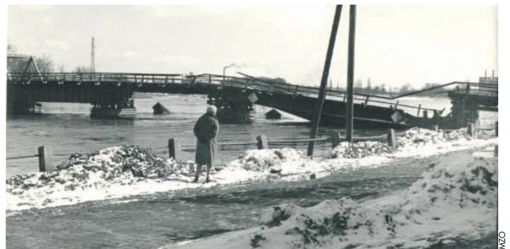
1963. Most na Odrze ze złamanym przęsłem. Pod mostem na zdjęciu widać w prześwitach między filarami izbice (lodołamy)
