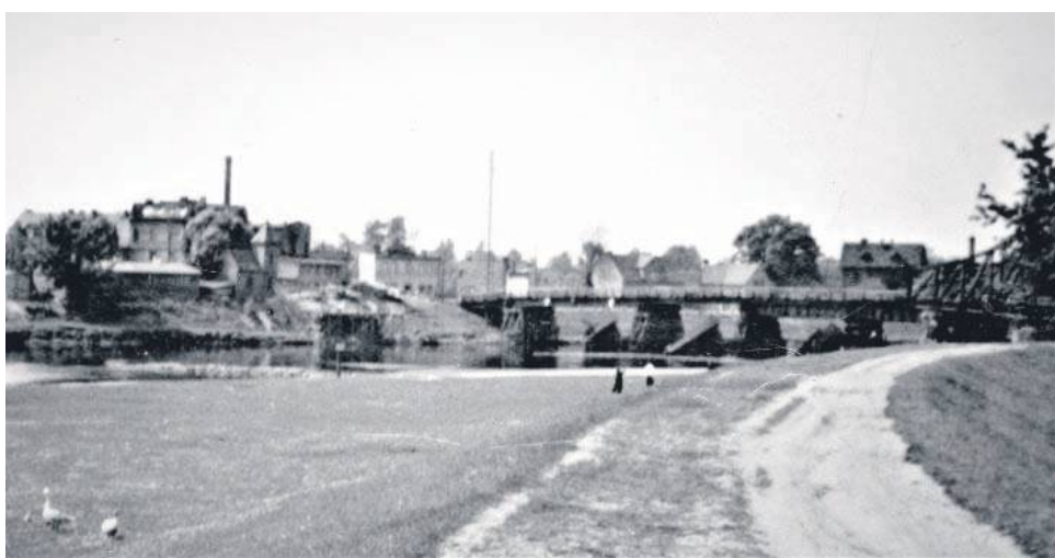
1955. Drewniany most na Odrze, zdjęcie z albumu Alicji Szypuły. Gdy się dobrze przypatrzemy, widoczne są przed filarami drewnianymi izbice, które chroniły filary przed lodem
