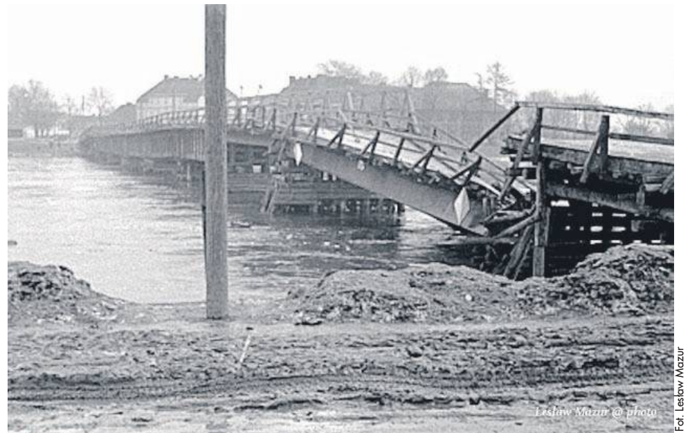
1963. Tak od strony rzeki wyglądał most ze złamanym przęsłem
