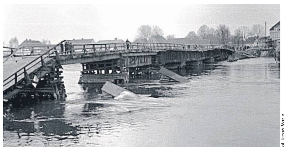
Most z zerwanym przęsłem - zdjęcie od strony śluzy - widać, w jakim jest stanie most, cały pofalowany. Budowano go na kilka lat używania, a służył 22 lata
