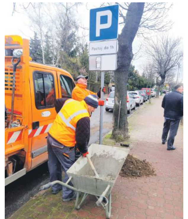
Nowe oznakowanie przy ulicy Sienkiewicza
