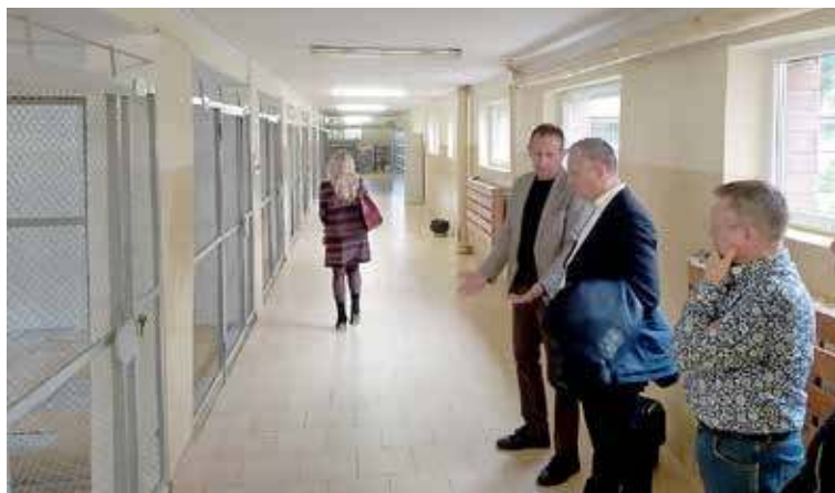
W planie remontów w II LO znalazła się również wymiana posadzek w szatniach
