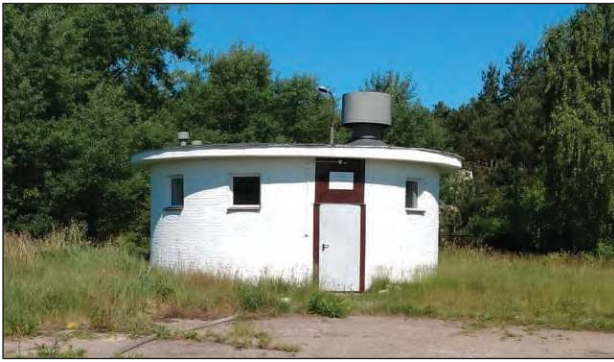
Charakterystyczny budynek w kształcie walca czekają prace remontowe
