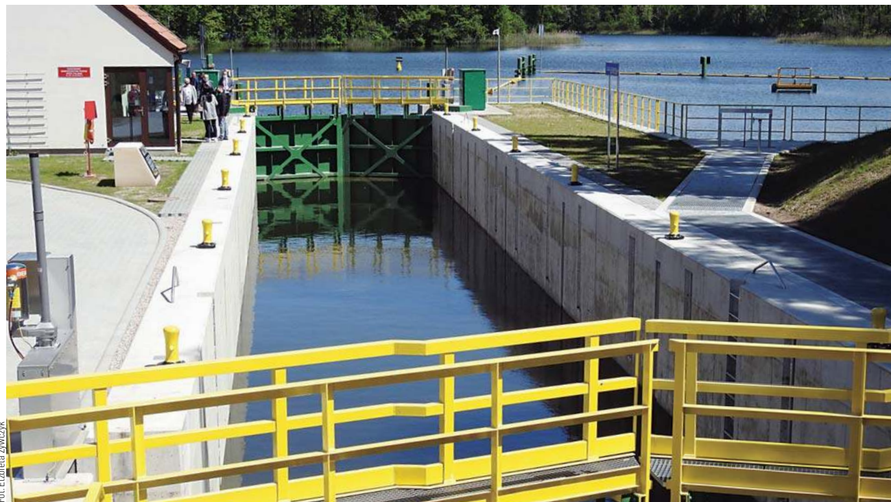
Śluza Guzianka II umożliwia żeglarzom przeprawę z jeziora Betdany na jezioro Guzianka Duża. Inwestycja kosztowała 30 mln zł, z czego dofinansowanie z RPO wyniosło 17 mln zł.
