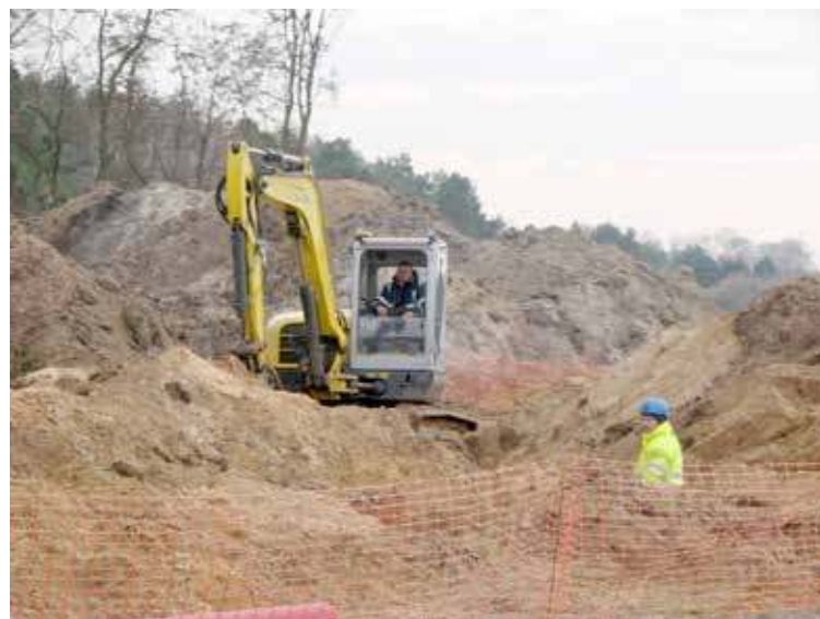
Obwodnica - pierwsze prace na ul. Pomorskiej
