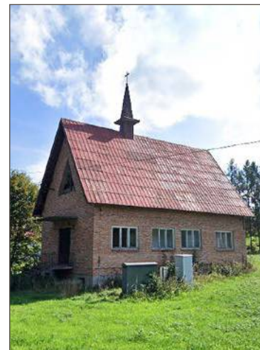
Coraz bliżej przebudowy kaplicy.
