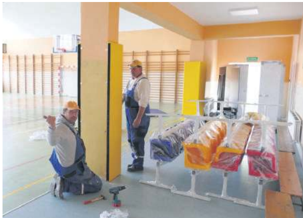
W trakcie modernizacji sali gimnastycznej w Zespole Szkolno-Przedszkolnym w Przewornie wykonano m.in. zabezpieczenie kolumn
