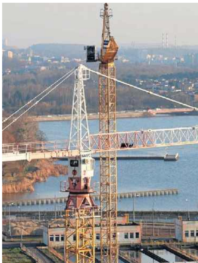
Budowę bloku gazowo - parowego rozpoczęto w 2024 r.
