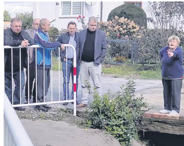
Komisja wysłuchiwała ostatnich uwag mieszkańców, a wykonawca zobowiązał się do usunięcia usterek
